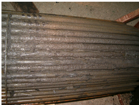
Slika br. 13. Detalj taloga mulja na cevnom registru
